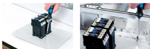
Монтаж устройств на монтажную плату
