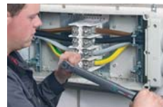
Клеммы должны быть затянуты с определенным усилием
