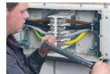
Клеммы должны быть затянуты с определенным усилием
