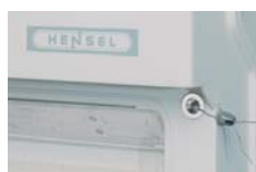
Пломбирование верхней и нижней части боксов KV
