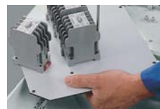
Монтаж устройств на монтажную плату
