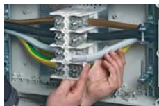
Проводники должны быть покрыты специальной смазкой, без содержания кислот и спиртов, и немедленно подключены
