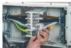
Проводники должны быть тщательно зачищены от окислов
