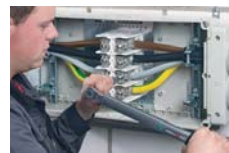
Клеммы должны быть затянуты с определенным усилием
