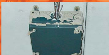
Ответвительные коробки с подключенными кабелями после теста
