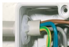
Фиксация кабеля с помощью фиксаторов KHR
