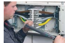
Клеммы должны быть затянуты с определенным усилием
