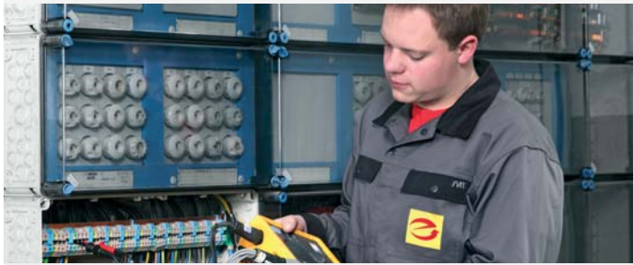
НКУ Mi распределения и управления на токи до 630 А, в соответствии со стандартом ГОСТ Р МЭК 61439 Часть 2
