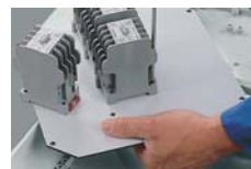
Монтаж устройств на монтажную плату
