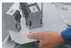
Монтаж устройств на монтажную плату
